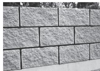
HOTOVÉ ZDÍVO: při precizním uzavření spár jsou spoje odolné vůči povětrnostním vlivům a mrazu a konstrukce po vyzráni výplňového betonu působí jako jeden monolitický celek.
