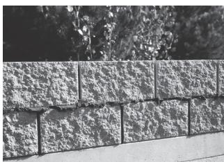
4. Vytlačovanou maltu odstraníme až po mírném zavadnutí, zabrání se tak možnému znečištění tvárnic.
