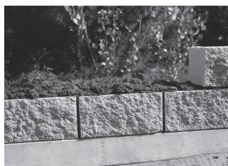
2. Vysoká vláčnost a přilnavost malty k tvárnici umožňuje rádné a celoplošné vyplnění spár.
