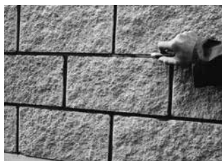
5. – 6. Murovanie a škárovanie prebieha v jednom úkone. Povrch škár sa uzavrie uhladením škárovacím hladidlom alebo upraveným dreveným kolíkom.
