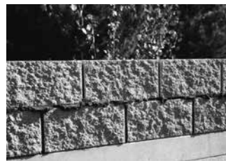
4. Vytlačanú maltu odstránime až po miernom zaschnutí. Zabráni sa tak možnému znečisteniu tvárnic.
