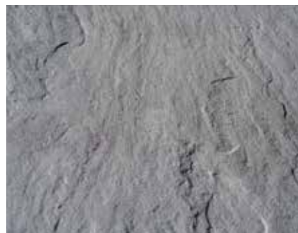
Po odstranění znečištění
