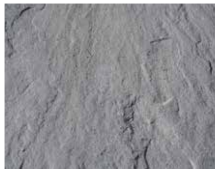
Po odstranění znečištění
