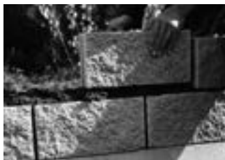
3. Malta vytlačovaná ze spár neodpadává a po seříznutí se dá znovu použít.
