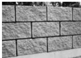
HOTOVÉ ZDIVO: při precizním uzavření spár jsou spoje odolné vůči povětrnostním vlivům a mrazu a konstrukce po vyzrání výplňového betonu působí jako jeden monolitický celek.
