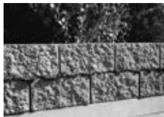
4. Vytlačovanou maltu odstraníme až po mírném zavadnutí, zabrání se tak možnému znečištění tvárníc.
