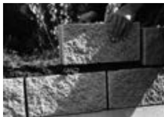
3. Malta vytlačaná zo škár neodpadáva a po odrezaní sa dá znovu použiť.
