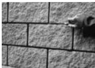
5. – 6. Murovanie a škárovanie prebieha v jednom úkone. Povrch škár sa uzavrie uhladením škárovacím hladidlom alebo upraveným dreveným kolíkom.
