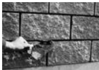
5. – 6. Murovanie a škárovanie prebieha v jednom úkone. Povrch škár sa uzavrie uhladením škárovacím hladidlom alebo upraveným dreveným kolíkom.
