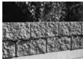
4. Vytlačanú maltu odstránime až po miernom zaschnutí. Zabráni sa tak možnému znečisteniu tvárník.
