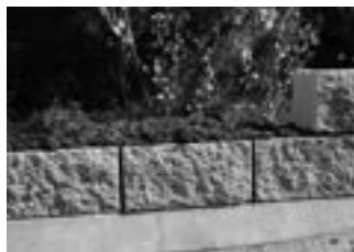
2. Veľká vláčnosť a priľnavosť malty k tvárnici umožňuje riadne a celoplošné vyplnenie škár.
