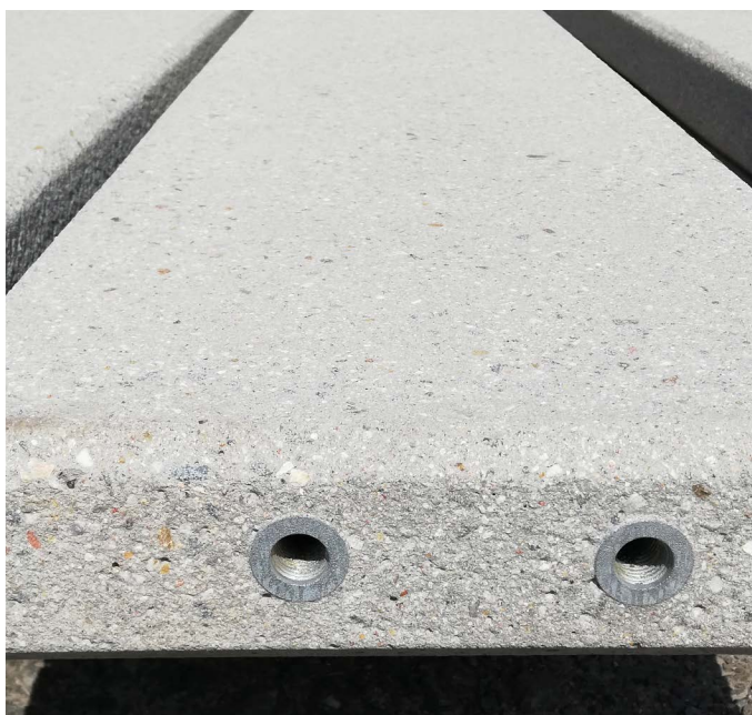
Tryskaný povrch a príprava pre kotvenie zábradlia (2x závitové puzdro pre skrutku M12 alebo M16)
