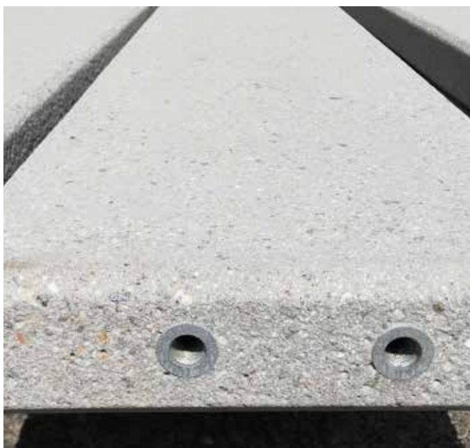
Trysaný povrch a príprava pre kotvenie zábradlia (2x závitové puzdro pre skrutku M12 alebo M16)
