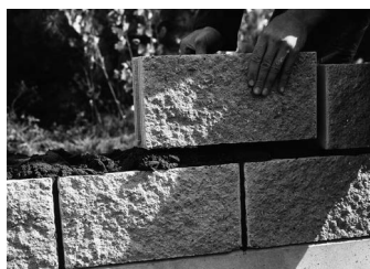
3. Malta vytlačovaná ze spár neodpadává a po seříznutí se dá znovu použít.
