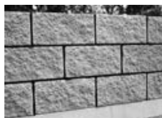
HOTOVÉ ZDIVO: při precizním uzavření spár jsou spoje odolné vůči povětrnostním vlivům a mrazu a konstrukce po vyzrání výplňového betonu působí jako jeden monolitický celek.
