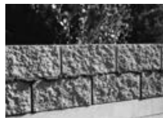
4. Vytlačovanou maltu odstraníme až po mírném zavadnutí, zabrání se tak možnému znečištění tvárníc.
