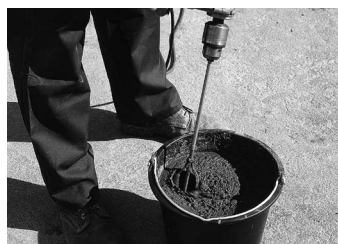
1. Suchou maltu lze rozmíchat s vodou v libovolné nádobě nebo v míchačce.
