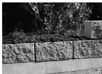
2. Veľká vláčnosť a príľnavosť malty k tvárnici umožňuje riadne a celoplošné vyplnenie škár.
