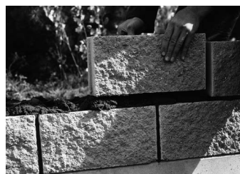
3. Malta vytláčaná zo škár neodpadáva a po odrezaní sa dá znovu použiť.
