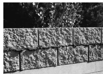
4. Vytláčanú maltu odstránime až po miernom zaschnutí. Zabráni sa tak možnému znečisteniu tvárník.
